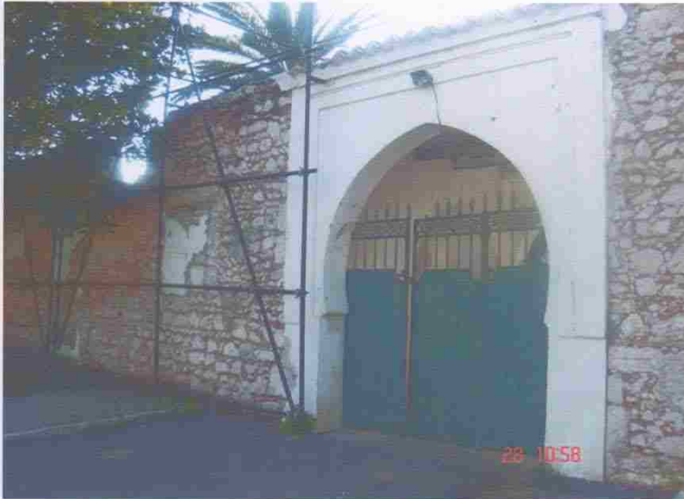
صورة 51: قصر الباي، المدخل الرئيسي.
