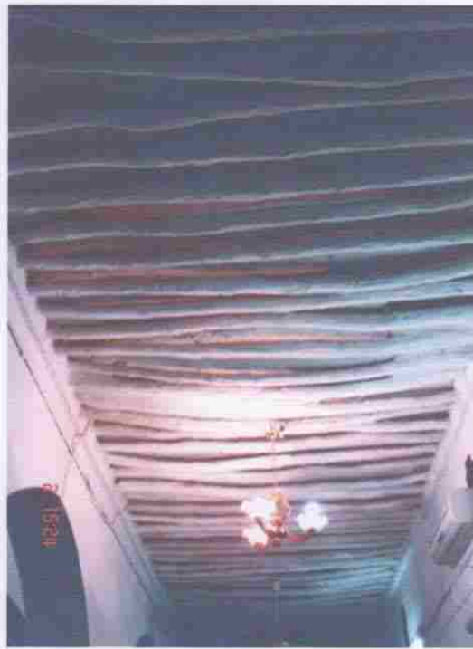
صورة 48: مسجد الباي ، سقف مسطح.
